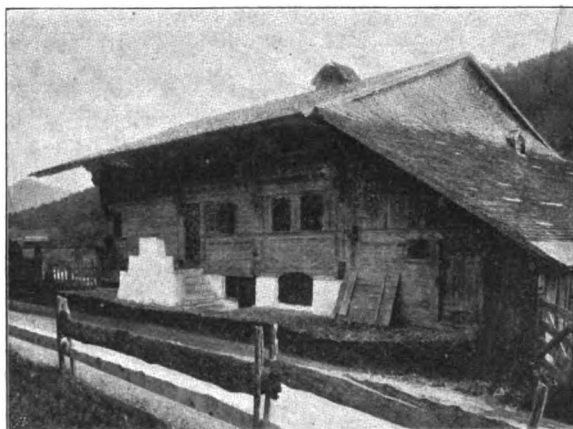
FIG. 245. — Chalet à Rougemont (S. M. H.).
